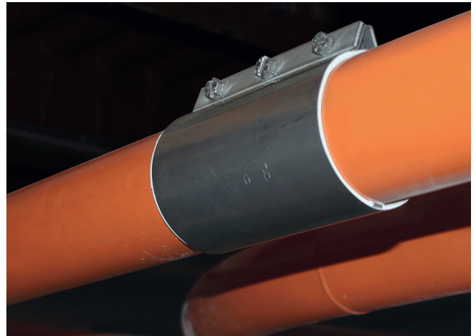
Fig.: Rohrkupplung an einem Transportrohr für Mehl in einer Bäckerei
